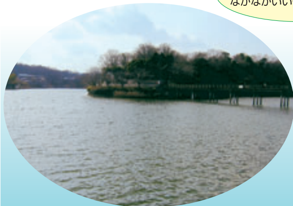
日本最古のダムといわれている「蛙股池」
